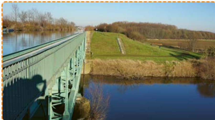
Das Wasserstraßenkreuz, Mittellandkanal und Leine kreuzen sich bei Garbsen
